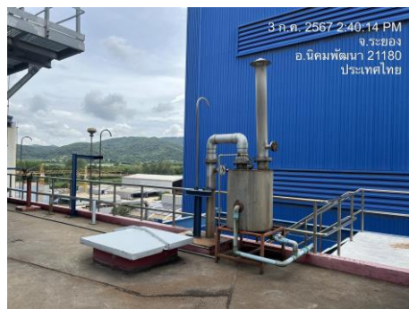
ภาพที่ 2.2-2 ระบบ Scrubber บริเวณปล่องหน่วยถังเตรียมสารเร่งปฏิกิริยา
